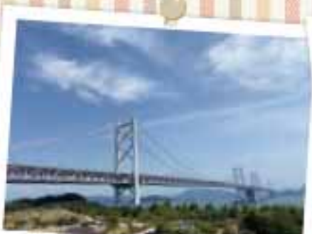
鳴門海峡 / 瀬戸大橋の雄姿を見ながら、位置する「鳴門海峡」の美しい景色です(左・右) 瀬戸の海峡を渡る橋は絶景♪
